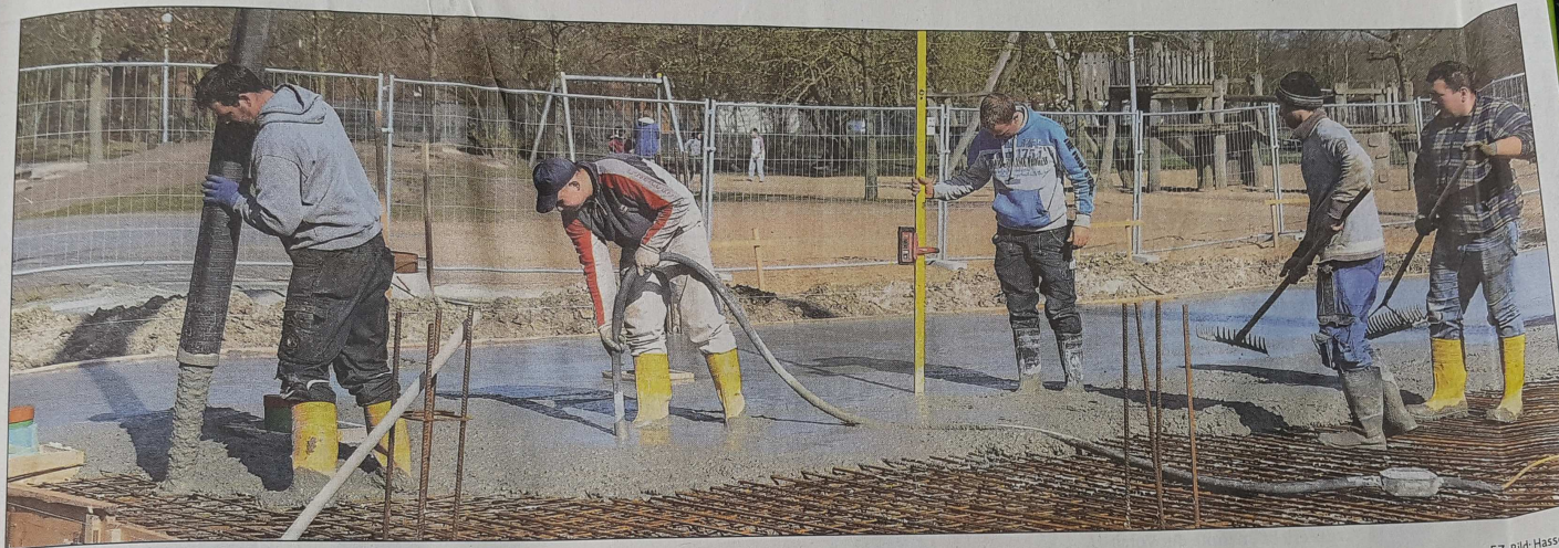
Beton marsch! Aus allen Rohren wurde gestern Mittag auf die Bewehrung aus Stahl „geschossen“.
